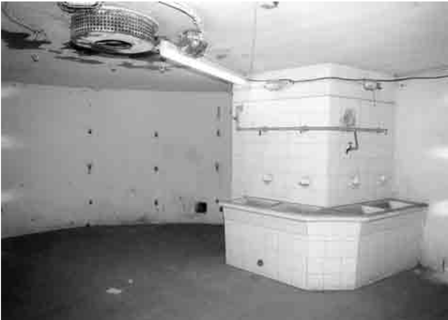
Mannschaftsraum mit Waschgelegenheit; Zustand 2000.
